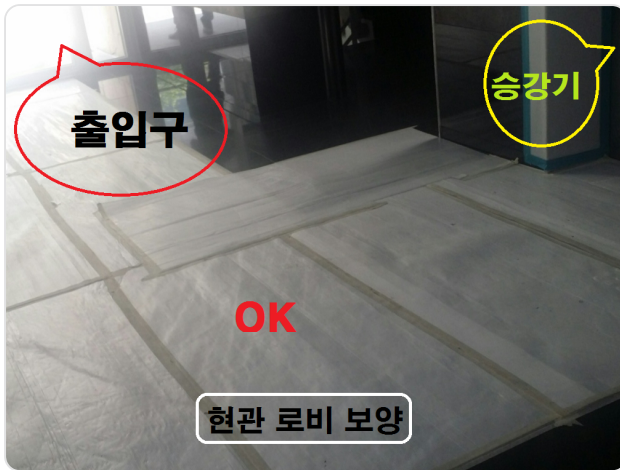
현관 로비 바닥 보양 — 출입구부터 승강기까지 전 동선
