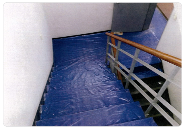
계단·복도 보양 — 디딤판, 난간 주변 및 출입문
